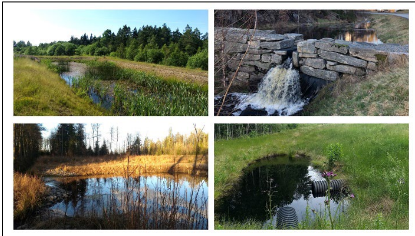
Figur 10. Exempel på dagvattendammar.
